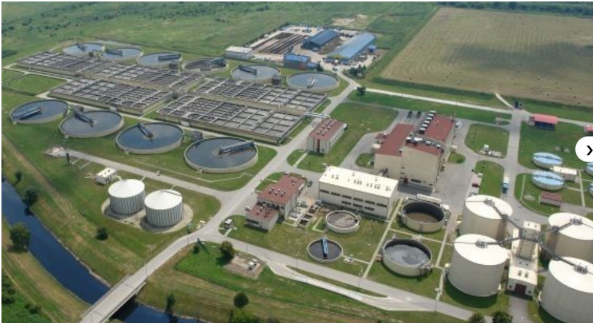
Rys. 1. Oczyszczalnia Kraków – Płaszów z lotu ptaka [6]
